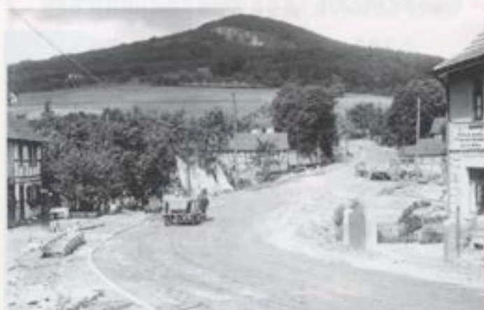
Im Bereich an der Linde /Hardtweg ist fast alles fertig
