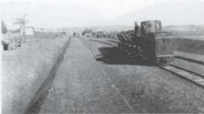
Auf Schienen: So sehen damals die Baufahrzeuge aus
