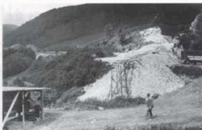
... der auf der anderen Seite wieder aufgeschüttet wird
