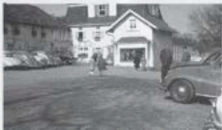
Der Thomashof am Ölbergringweg war noch in den 60er Jahren ein beliebtes Ausflugsziel.
