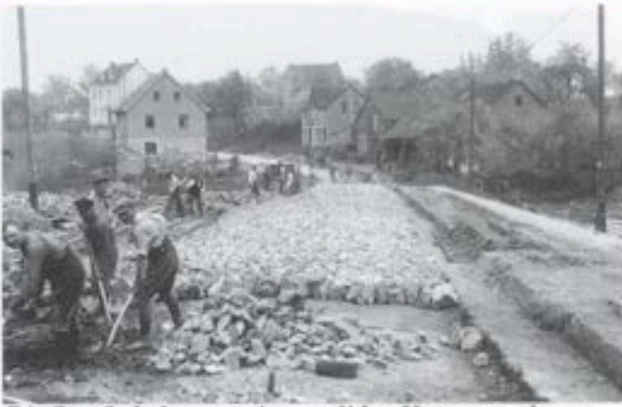
Die Straße bekommt einen soliden Untergrund
