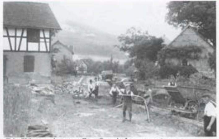
Die Königswinterer Straße wird erneuert
