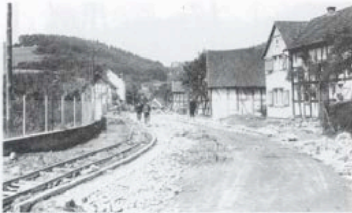
Noch liegen die Baugleise im Ort
