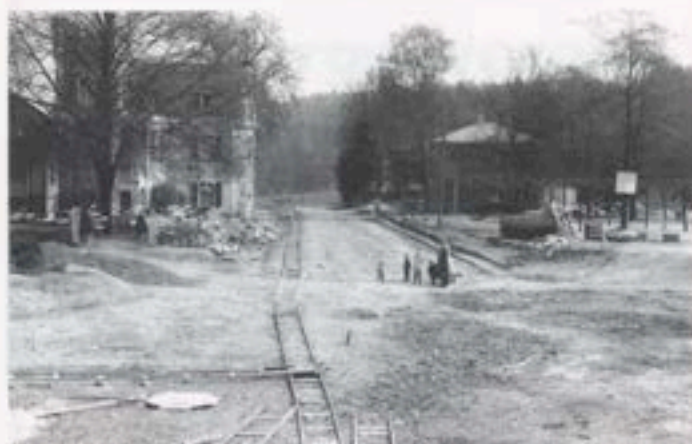
Auf der Margarethenhöhe liegen Schienen für Bauloren
