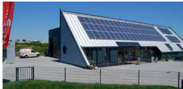
Wärme für Brauchwasser und für die im gesamten Büro- und Verwaltungsbereich verlegte Fußbodenheizung. Die innovative Einbindung der thermischen Solaranlage an die Wärmepumpe bewirkt, dass bei kühleren Außentem-
