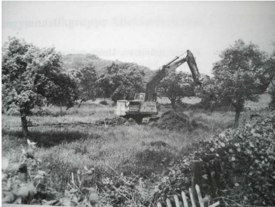
Der erste Aushub zum Bau der Turnhalle 1983 / 84
